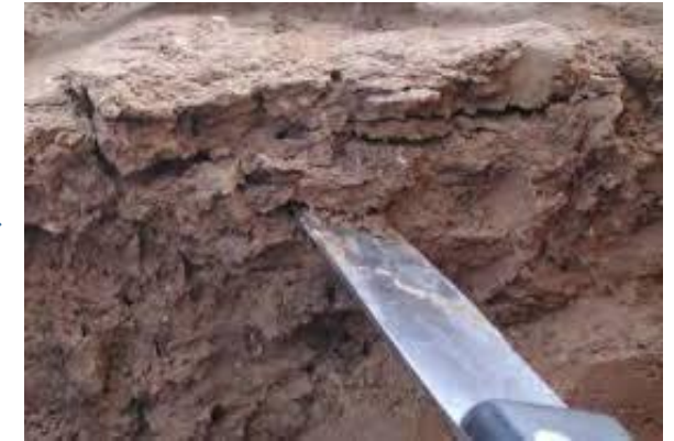
Compaction du sol
